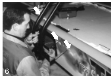
6 INTRODUCIR CABLES Y AMARRAR -H- INSERT WIRING AND ANCHOR -H-.
